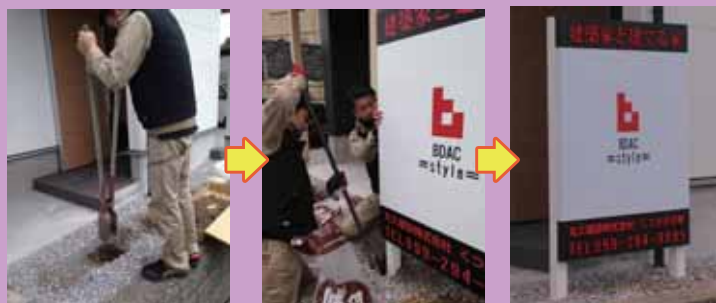
地面に穴を掘る → 水平機で水平を測る → 《完成!!》
